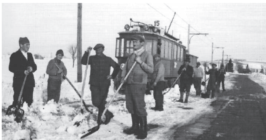
Une solide équipe d'agriculteurs vient prêter main-forte au personnel de la CGTE pour permettre le passage, entre Laconnex et Cartigny, du convoi qui se rend à Chancy en 1924.
