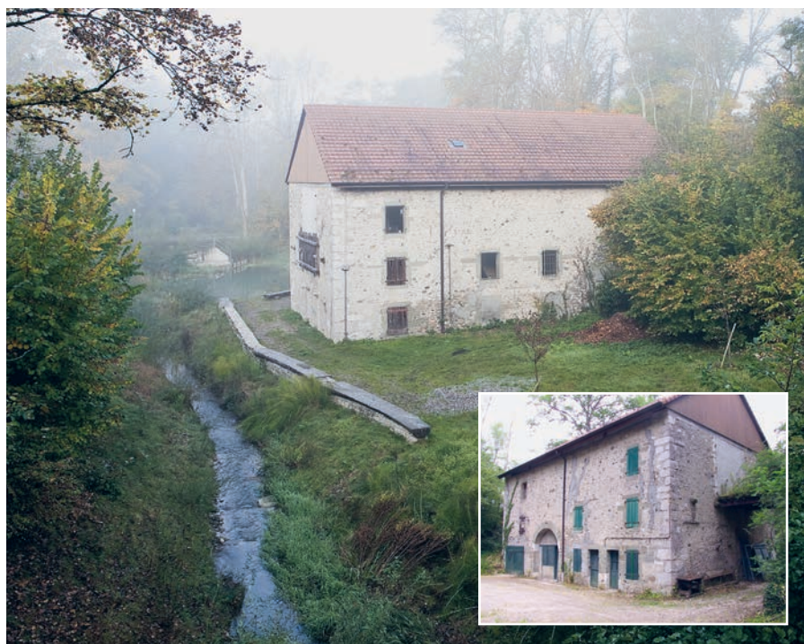
Le bâtiment, avant (petite photo) et après la renaturation du nant de Couchefatte, en 2008.
