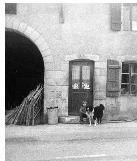
Début des travaux : aménagement de la grange
