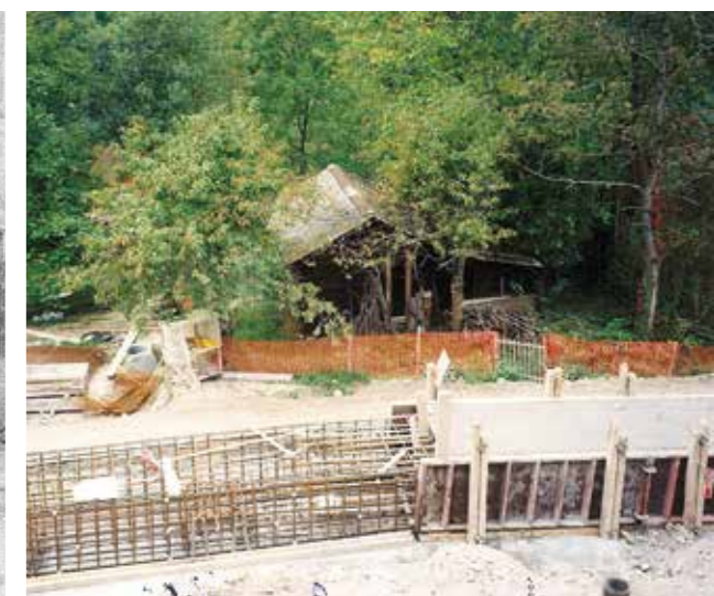
1998, les travaux de construction du mur commencent
