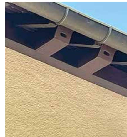
Quelques-uns des nichoirs installés à la salle communale
