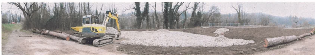
Deuxième étape : Renaturation du site.
