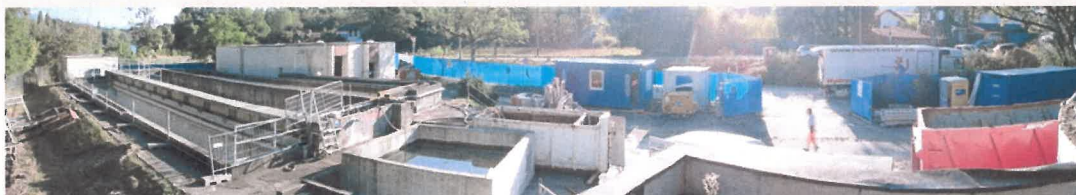
Première étape : Démolition de l'ancienne STEP de Chancy.
